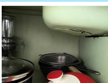
Matériaux : Z06 - Cuisine - Insonastic - Plaque antivibratile Prélèvement : P006 Description : plaque antivibratile Localisation : Bat 1 - Cuisine - Insonastic Résultat : Présence d'amiante
