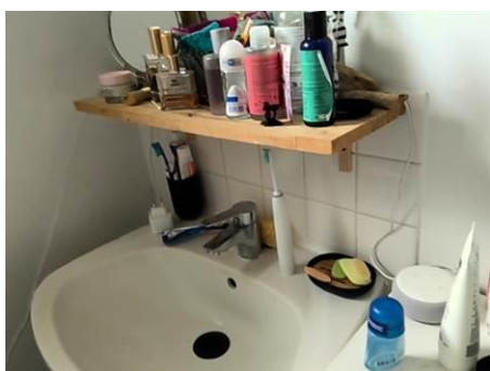
Matériaux : Z07 - Salle d'eau - Faïence 10x10 - Colle de faïence Prélèvement : P009 Description : colle de faïence Localisation : Bat 1 - Salle d'eau - Faïence Résultat : Présence d'amiante
