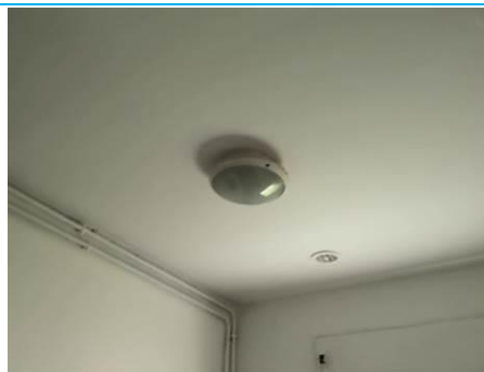
Matériaux : Z02 - Cuisine, Salle d'eau - Plafond - Peinture + enduit Prélèvement : P008 Description : enduit + peinture Localisation : Bat 1 - Salle d'eau - Plafond Résultat : Présence d'amiante
