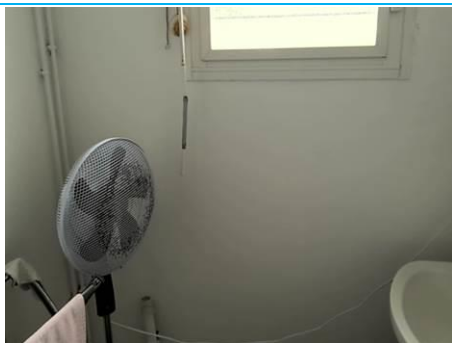
Matériaux : Z01 - Cuisine, Salle d'eau - Mur - Peinture + enduit Prélèvement : P007 Description : enduit + peinture Localisation : Bat 1 - Salle d'eau - Mur Résultat : Présence d'amiante
