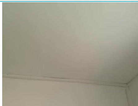
Matériaux : Z02 - Cuisine, Salle d'eau - Plafond - Peinture + enduit Prélèvement : P002 Description : enduit + peinture Localisation : Bat 1 - Cuisine - Plafond Résultat : Présence d'amiante
