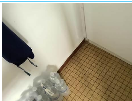
Matériaux : Z04 - Cuisine, Salle d'eau - Plinthe 15x10 - Colle de plinthe Prélèvement : P004 Description : colle de plinthe Localisation : Bat 1 - Cuisine - Plinthe Résultat : Présence d'amiante
