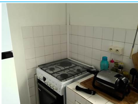
Matériaux : Z03 - Cuisine, Salle d'eau - Faïence 15x15 - Colle de faïence Prélèvement : P003 Description : colle de faïence Localisation : Bat 1 - Cuisine - Faïence Résultat : Présence d'amiante
